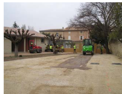
Utilisation d'enrobé végétal pour la cour du CLSH
